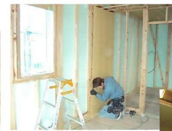
断熱材をはめ込み、その上にプラスチカードを貼っていきます。
