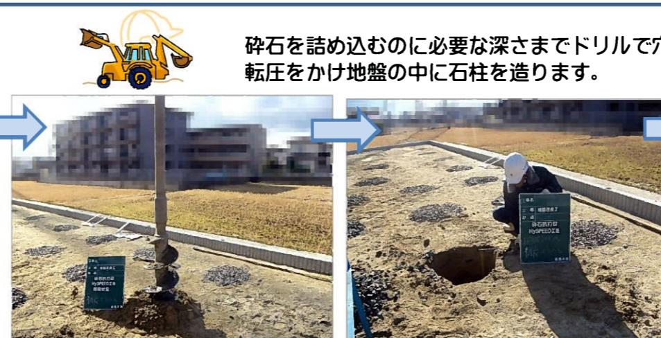
碎石を詰め込むのに必要な深さまでドリルで穴を掘り、その穴に碎石を詰め込み、
