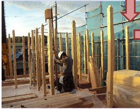
2階部分の柱が立てられていきます。
