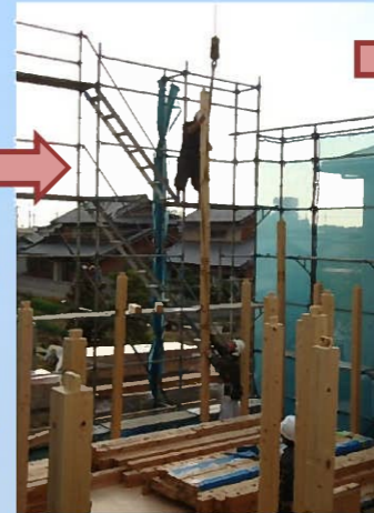
穴の位置を確認しながら柱へはめ込みます。
