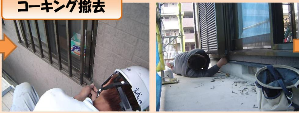
劣化したコーキングを外壁やサッシを破損しないよう、慎重に剥がします。根気のいる作業です(>\_<)
