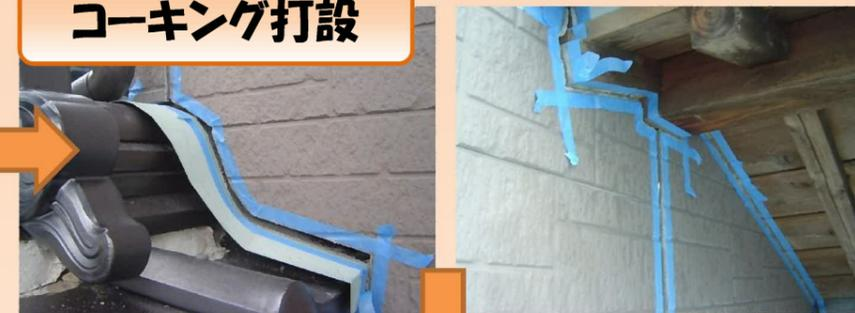
コーキングで汚れてしまわないように、養生テープで周りを保護し、コーキングを打設していきます。
