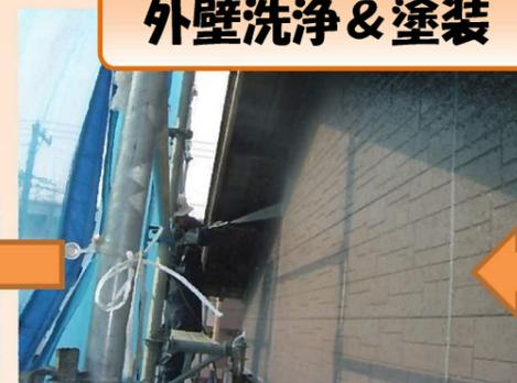
高圧洗浄機で汚れを一気に洗い落とします！
