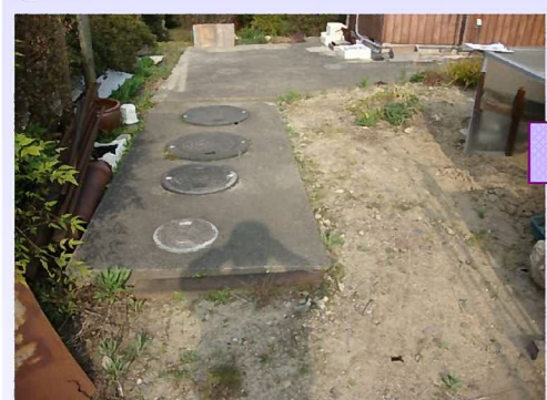
浄化槽から下水道への切り 替え工事です。 下水道への切り替え後、 浄化槽は雨水枡として使用 します。
