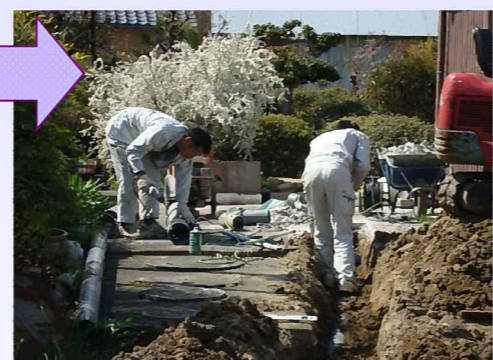
下水道本管へ繋ぐ為、新たに 管を埋設します。
