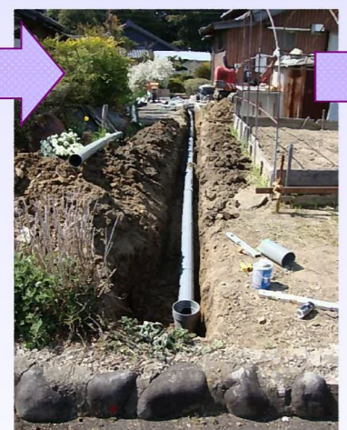
下水道本管へ繋ぐ為、新たに 管を埋設します。
