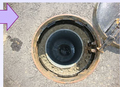
下水道本管への切り替え 完了~(o)
