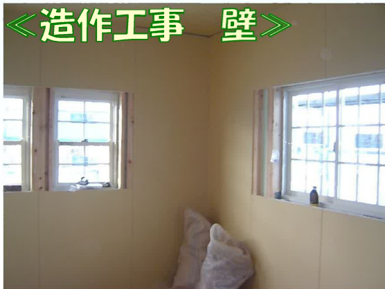
下地材の石膏ボードが張られ、部屋らしくなってきました(^_^)
