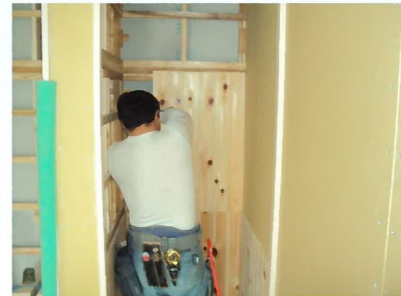
収納部分には、松の小幅板を張っていきます。松は防虫・防湿効果もあるので、収納部分の 材質としても最適ですよ~(^o^)/
