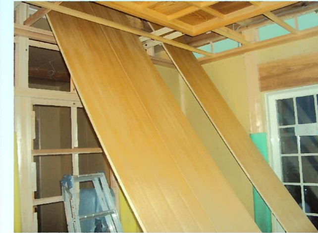
和室に使用する天井板に荏油(えあぶら)を塗っていきます。 手垢や汚れの防止、艶出しに効果があります。
