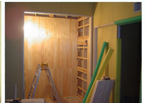
収納部分には、松の小幅板を張っていきます。松は防虫・防湿効果もあるので、収納部分の 材質としても最適ですよ~(^o^)/
