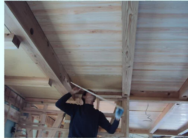
リビングの天井は、現し梁に松小幅板張りで仕上げられています。 一枚一枚丁寧に張っていきます(^_^)
