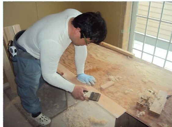
収納部分には、松の小幅板を張っていきます。松は防虫・防湿効果もあるので、収納部分の 材質としても最適ですよ~(^o^)/
