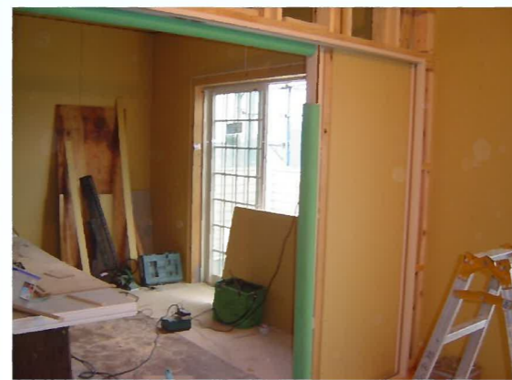
下地材の石膏ボードが張られ、部屋らしくなってきました(^_^)
