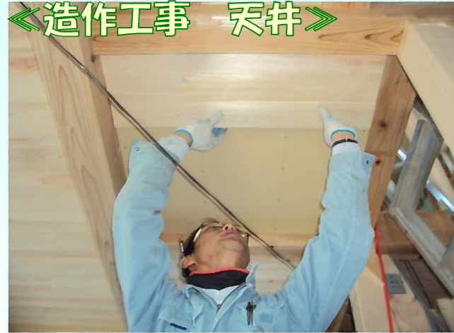
リビングの天井は、現し梁に松小幅板張りで仕上げられています。 一枚一枚丁寧に張っていきます(^_^)
