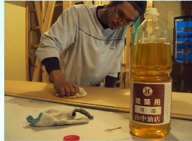
和室に使用する天井板に荏油(えあぶら)を塗っていきます。 手垢や汚れの防止、艶出しに効果があります。
