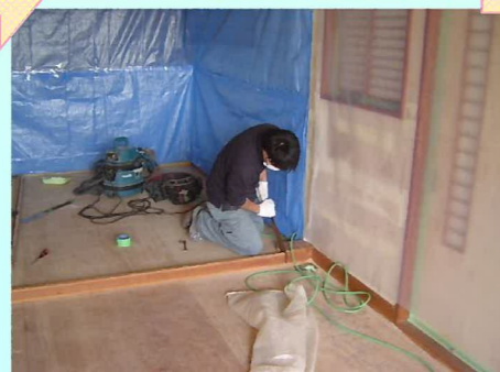
絨毯を剥がして、畳コー ナー部分は撤去してい きます。
