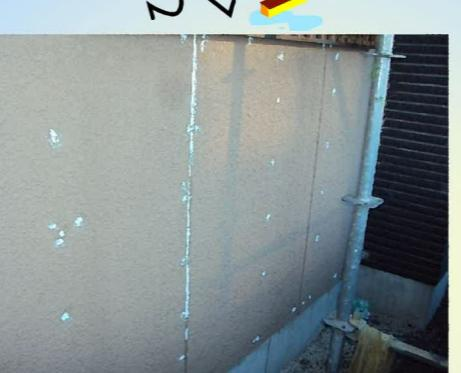
窓や雨戸の部分に塗料が付かないように養生をしてから塗装工事に入ります。
