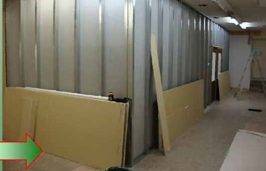
壁紙をはがし、間仕切壁を ばらしていきます。
