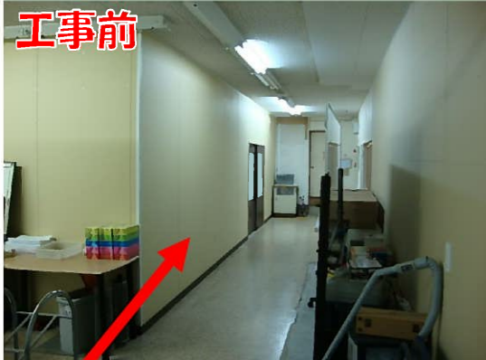
工事前 この間仕切壁を撤去して、 区切られていたフロアを 一つのフロアにします(^o^)
