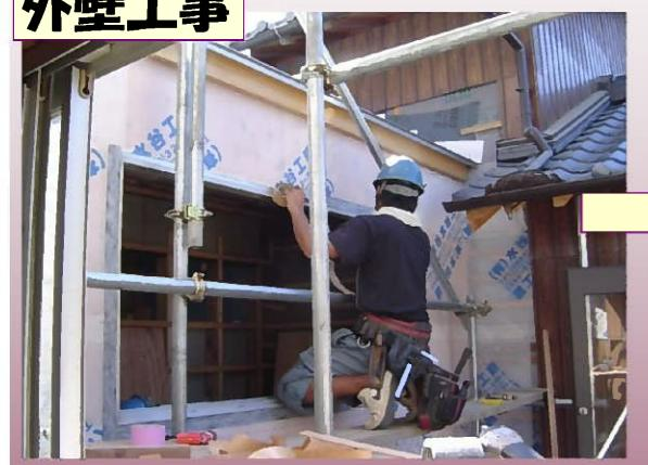
防水シートが張られ、窓枠部分には水漏れを防ぐため、防水テープを張っています。
