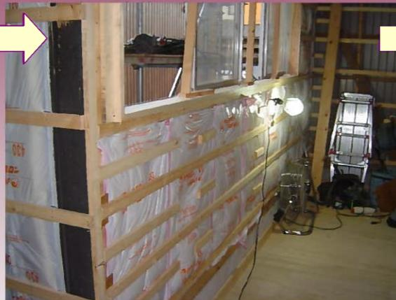
壁には断熱材が充填され、壁や天井が張られていきます。
