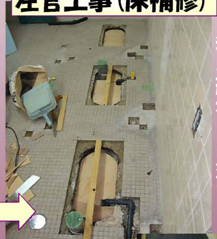
左官工事(床補修)
