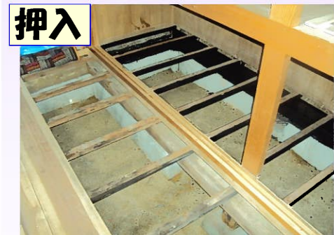
傷んでいた押入の床板を剥がし、防腐防蟻剤のスーパーカーボンコートを塗布し、床板を張り直しました。
