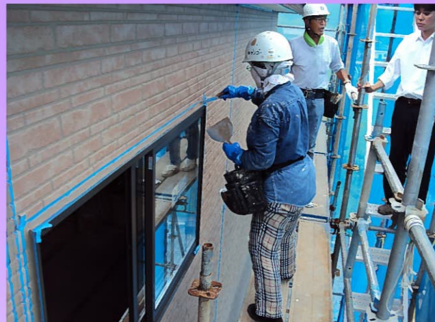
外壁のつなぎ目にコーキングが施され、外装工事は完了です！
