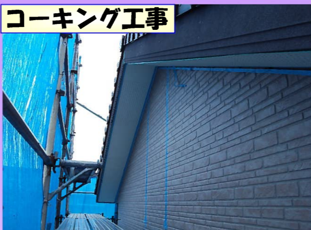
外壁のつなぎ目にコーキングが施され、外装工事は完了です！
