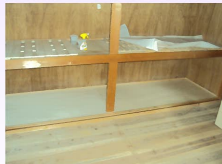
傷んでいた押入の床板を剥がし、防腐防蟻剤のスーパーカーボンコートを塗布し、床板を張り直しました。
