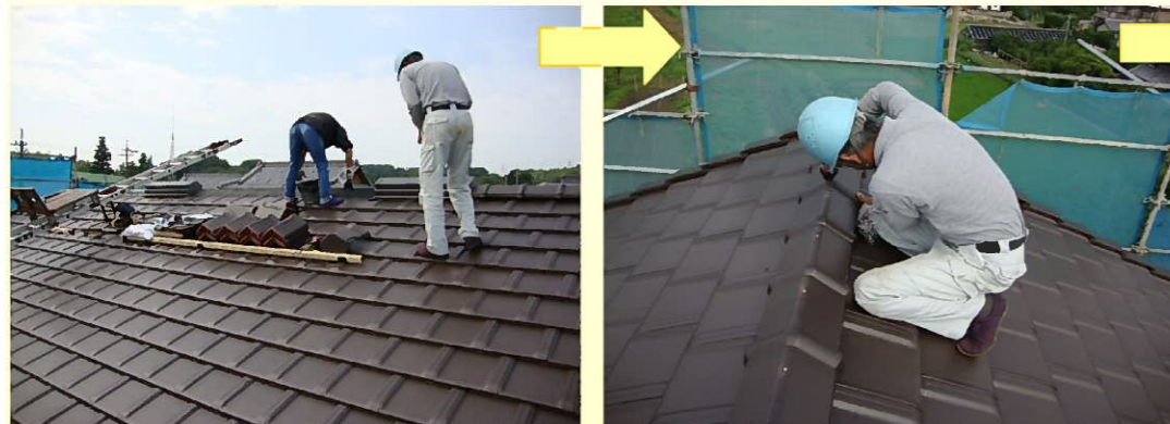
瓦が一枚ずつ並べられ、固定されていきます。 職人技が光ります！
