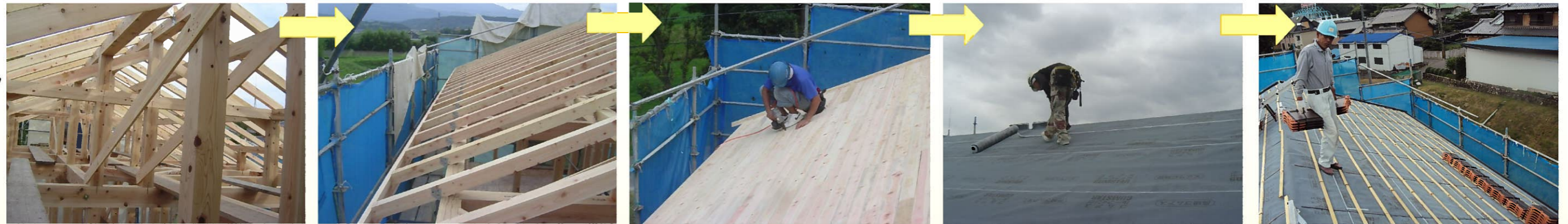
完成してしまうと見ることができない小屋組の部分です。 屋根の部分ってこんな風になっているんですね~(^o^)
