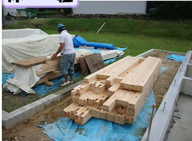
熊野産の桧材と杉材が搬入され、建前に向けて桧材の床が組まれていきます。
