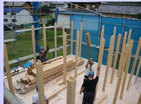
2階部分の床が組み、柱が建てられていきます。
