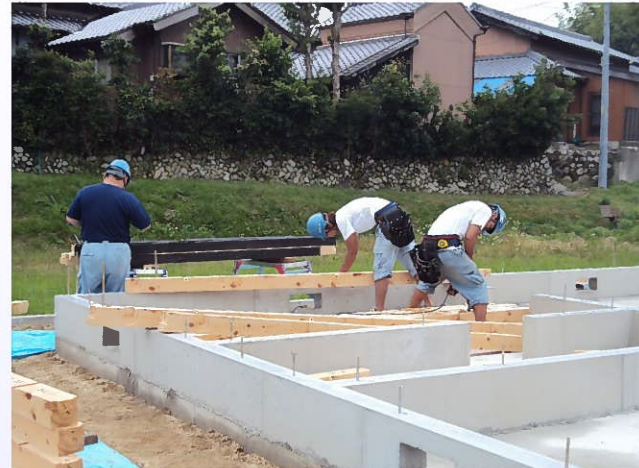
熊野産の桧材と杉材が搬入され、建前に向けて桧材の床が組まれていきます。
