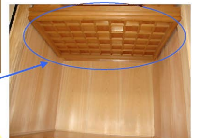
ちょっとわかりづらいですが...格子天井で仕上げてあります。
