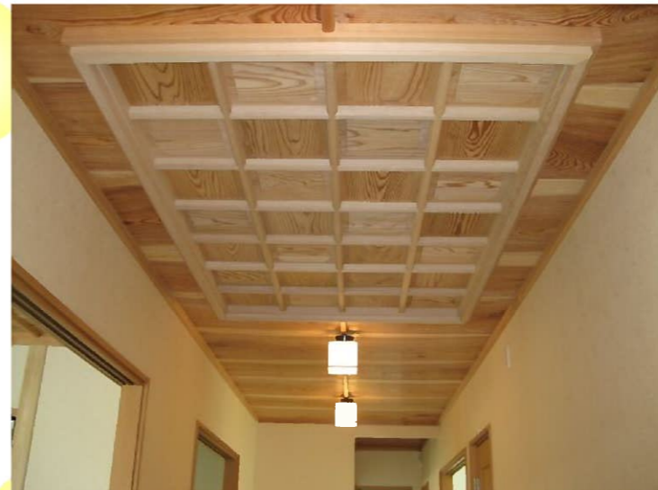
廊下天井は、幅三尺の地松と杉の格子天井にて仕上げました。
