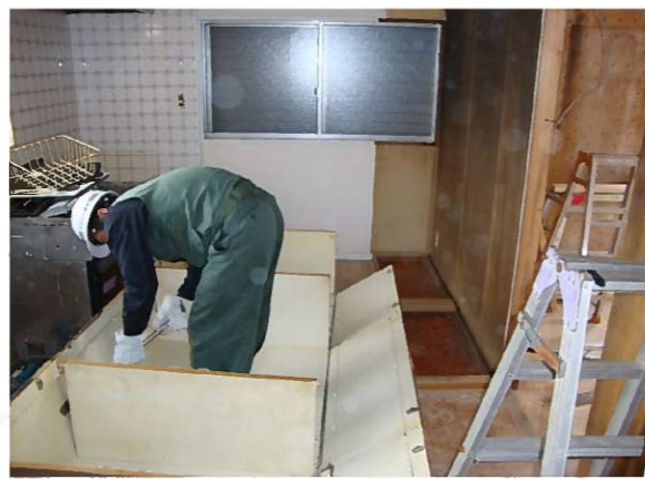
↑ 作り付けの棚を壁から外し、 解体していきます
