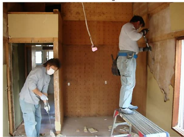
↑ 作り付けの棚を壁から外し、 解体していきます
