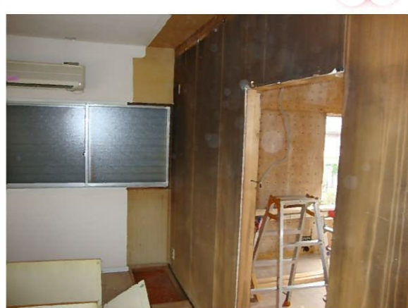
↑ 作り付けの棚を壁から外し、 解体していきます
