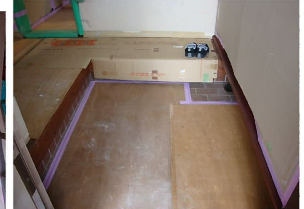
解体工事完了後、既存の柱や壁に 傷や汚れが付かない様に養生を 施してから工事に取り掛かります
