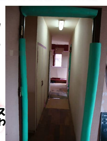
解体工事完了後、既存の柱や壁に 傷や汚れが付かない様に養生を 施してから工事に取り掛かります
