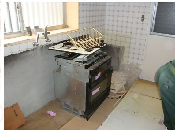
ガスコンロを使用していましたが、 改修後はIHヒーターコンロに 変更されます
