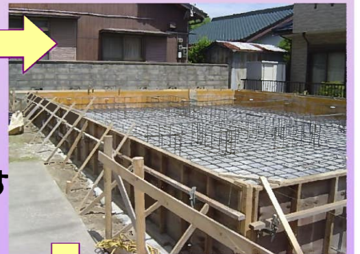
基礎配筋完成～
