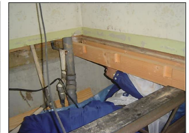
土台にドリルで穴を開け、白蟻駆除用の薬品を打ち込んでいきます
