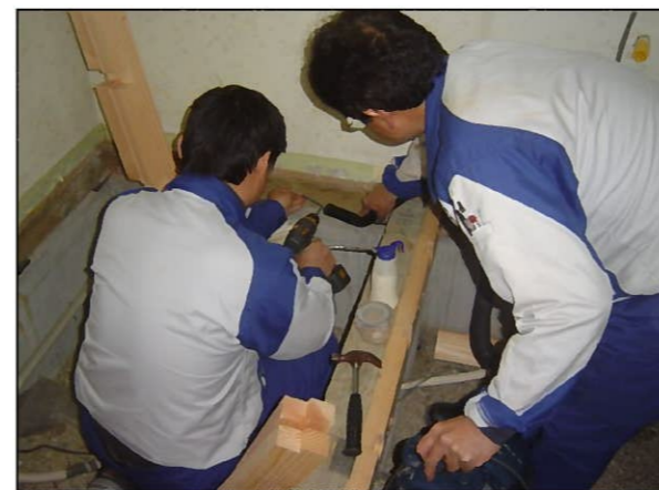
土台にドリルで穴を開け、白蟻駆除用の薬品を打ち込んでいきます
