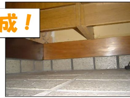
土台にドリルで穴を開け、白蟻駆除用の薬品を打ち込んでいきます
