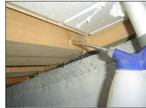
土台にドリルで穴を開け、白蟻駆除用の薬品を打ち込んでいきます
