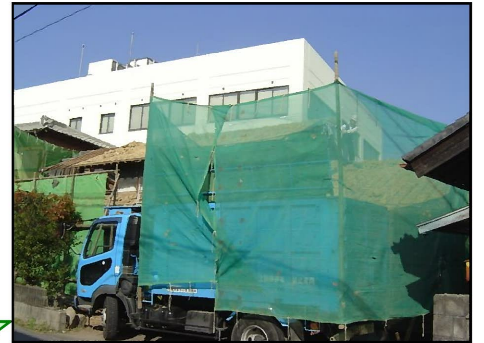
飛散防止ネットにて周りに飛ばない様に
