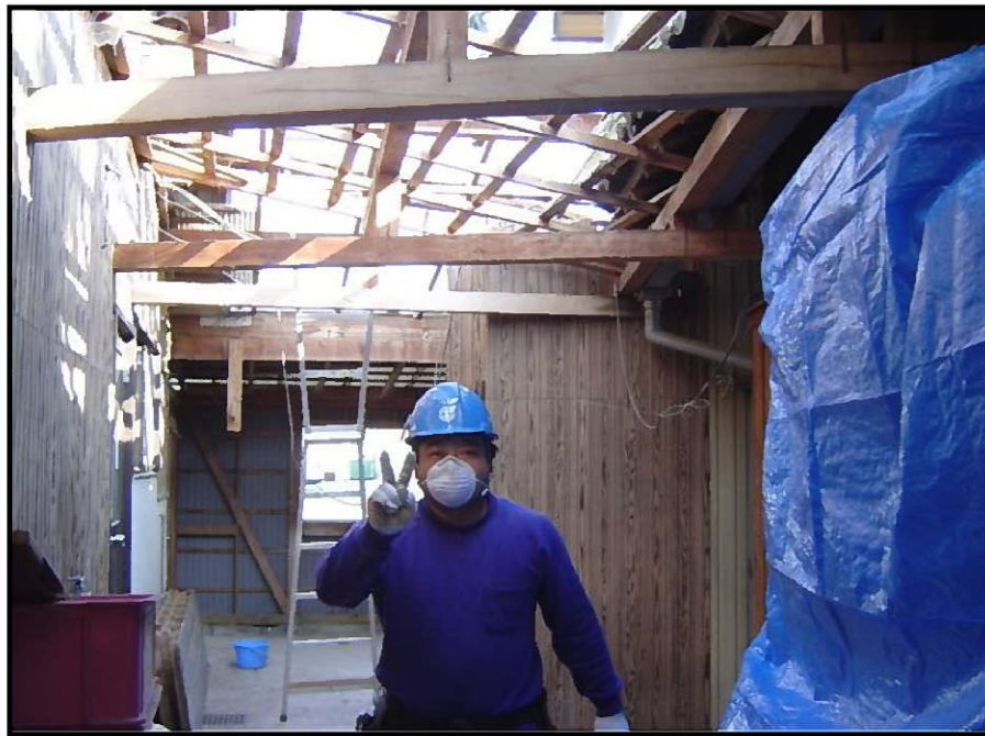
3つの建物を手作業にて切離しています
