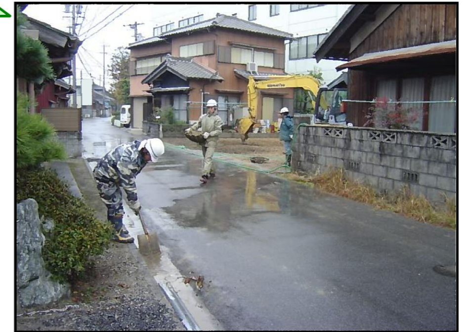
一日の工事終了時には道路を洗浄して完了です
