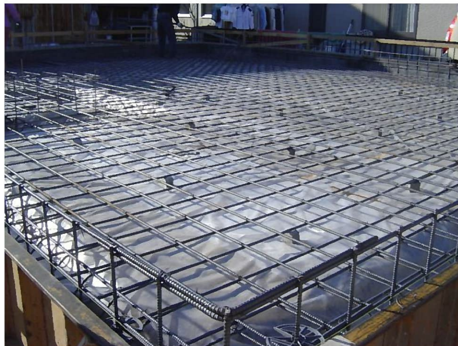
きれいな配列の鉄筋でしょ！(^o^)
