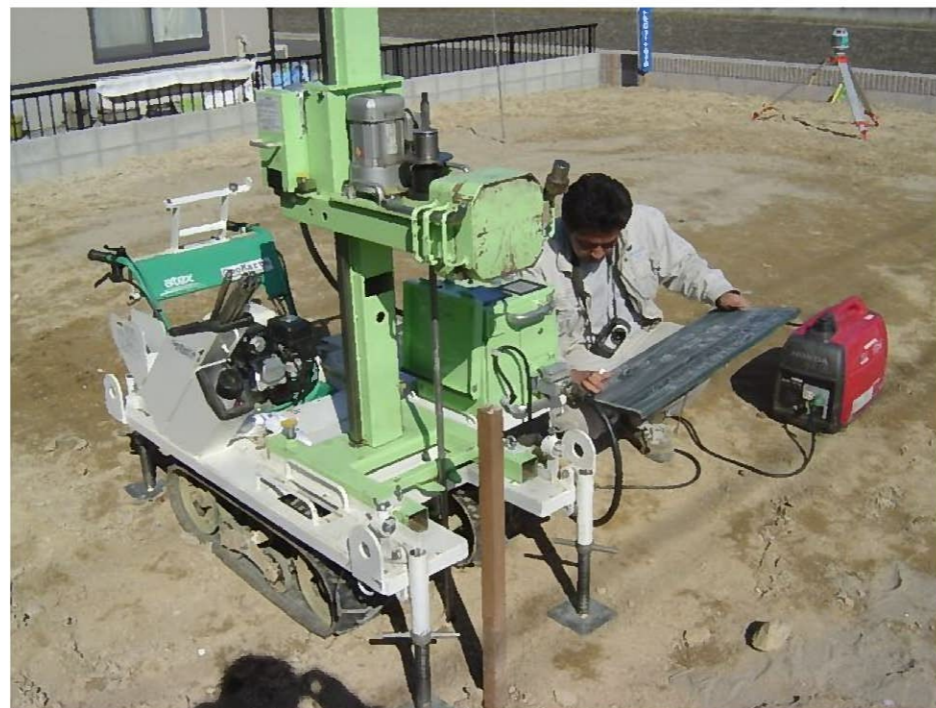
地盤調査を行い、地盤改良・基礎を考えます
