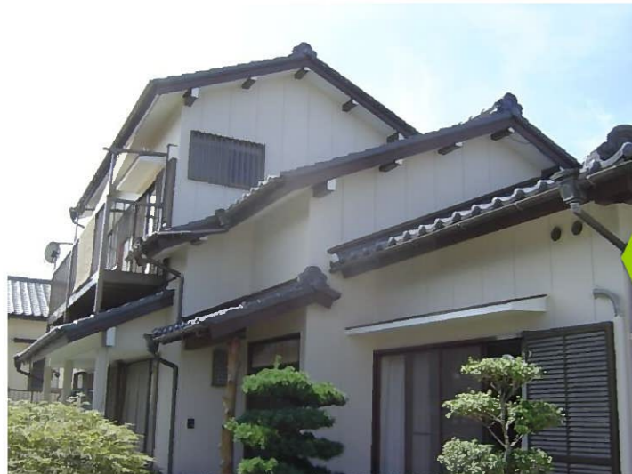
工事完了です！
