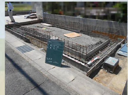
既定の寸法で組んであるかスケールを使って寸法を確認します。
