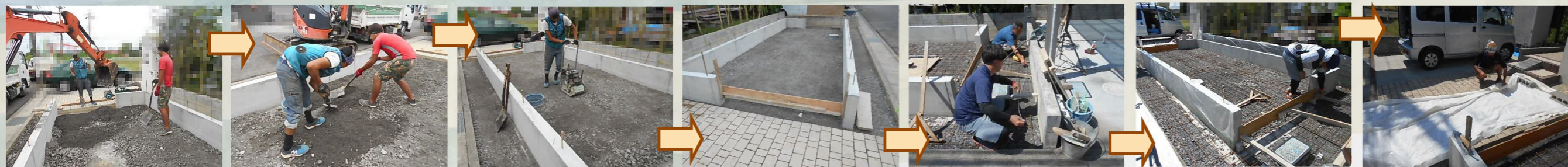
土間工事です！ 砕石を均していきます。
