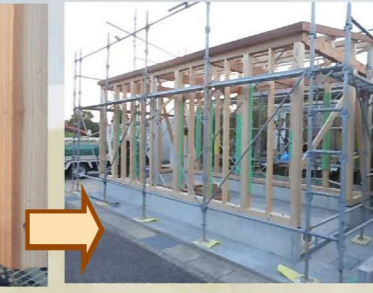
順番に柱を立てていきます。 土台と柱がぴったりと納まっていきます。
