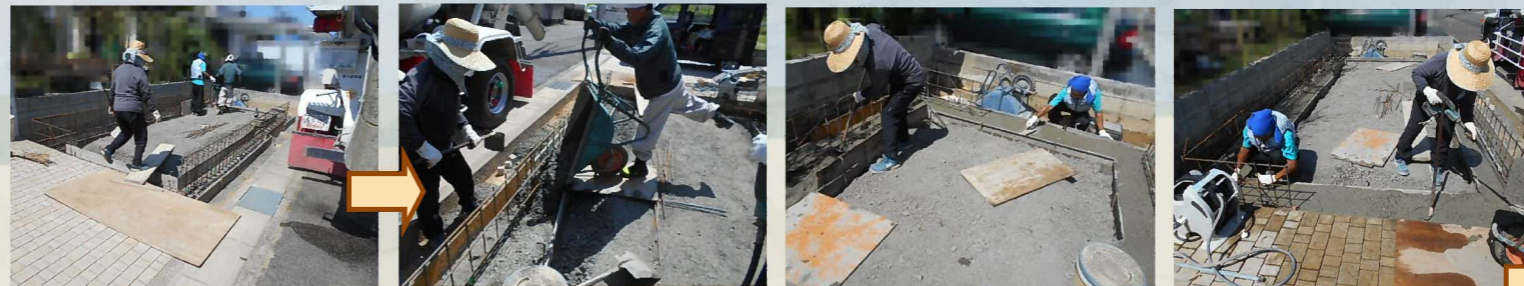
最後に清掃をして、ベース部分の生コン打設完了です。
