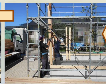
順番に柱を立てていきます。 土台と柱がぴったりと納まっていきます。
