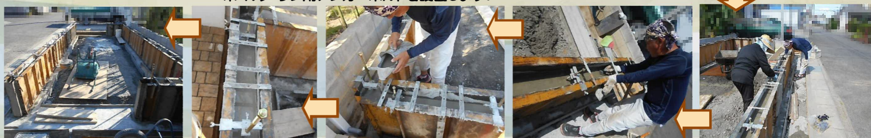
立上り基礎の打設完了です。
