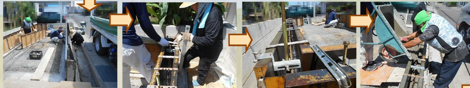
ホールダウン用アンカーボルトを設置します。
