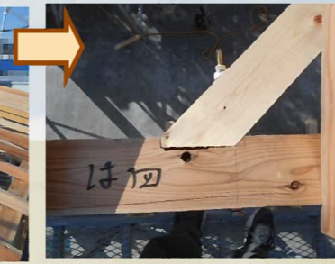
順番に柱を立てていきます。 土台と柱がぴったりと納まっていきます。
