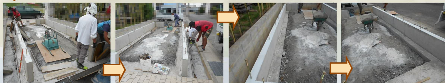
4日間ほど養生期間の後、型枠をばらして形を整えて基礎工事完了です！
