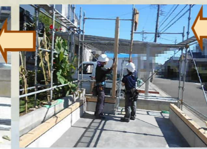
順番に柱を立てていきます。 土台と柱がぴったりと納まっていきます。
