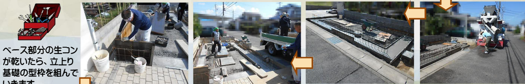
最後に清掃をして、ベース部分の生コン打設完了です。
