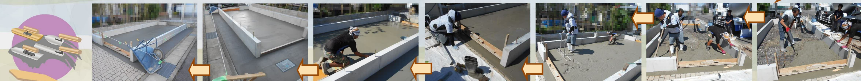
土間工事完了です！ 綺麗に仕上がりました(^_^)v
