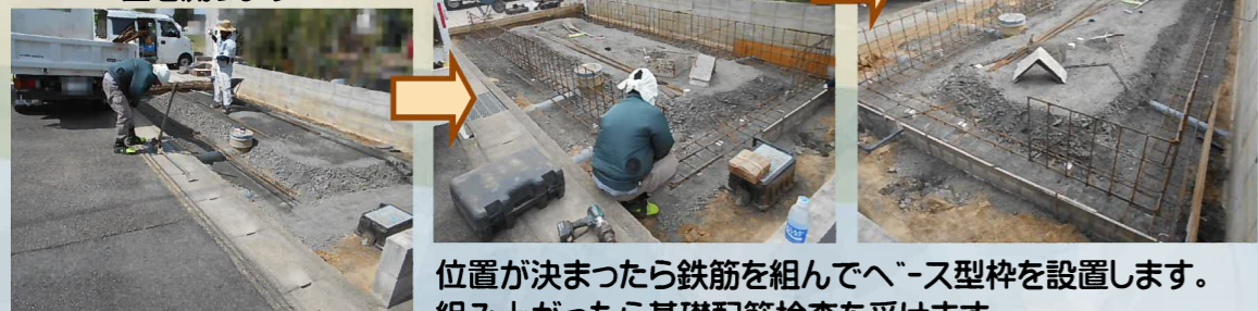
ベースを組むために 図面を基に設置位置を測ります。
