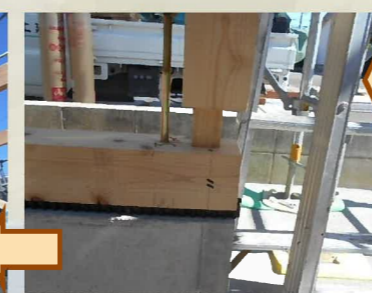
順番に柱を立てていきます。 土台と柱がぴったりと納まっていきます。
