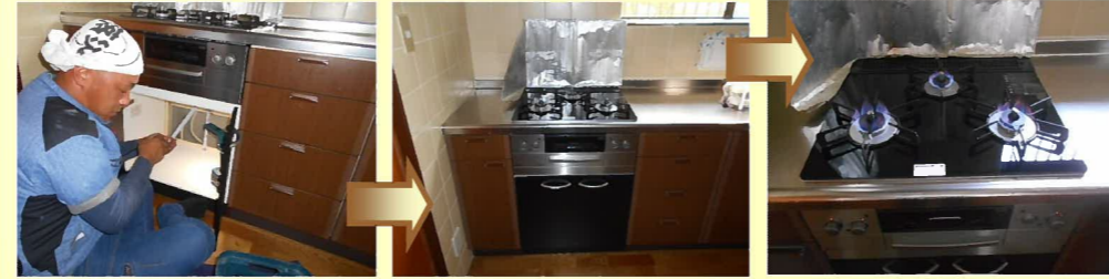
ガスの配管とコンロをつなげて工事完了です(^o^)/
