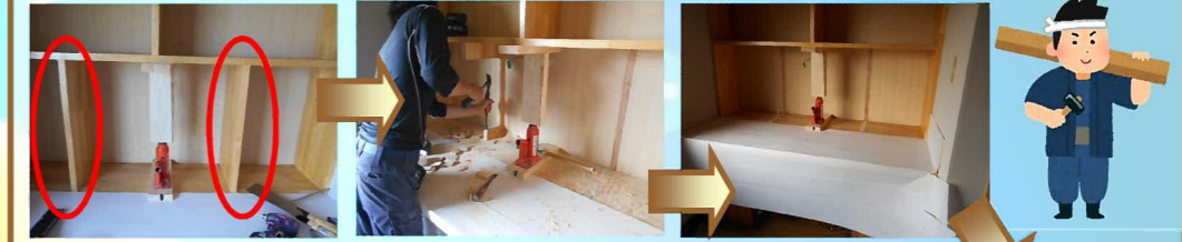
両サイドの間仕切りを撤去します。
