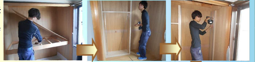
中段を撤去して可動棚を組み上げます。
