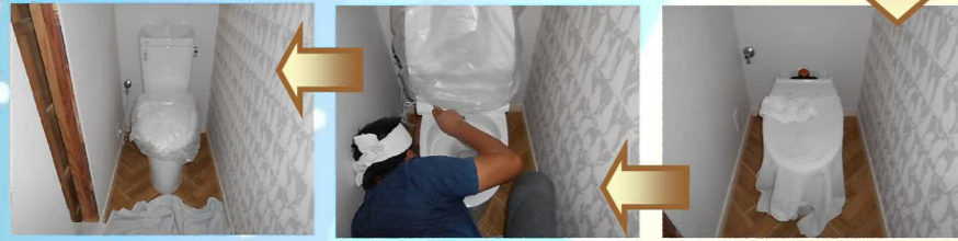
便器とタンクが納まりました！ 便器の座り具合を確認しながら取り付けます。
