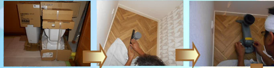
部材が運び込まれ、配管を取り付けていきます。
