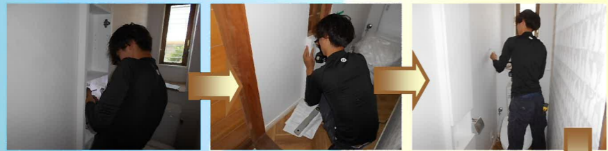
壁に埋め込みタイプのキャビネットやタオルリング、ペーパーホルダーを取り付けます。
