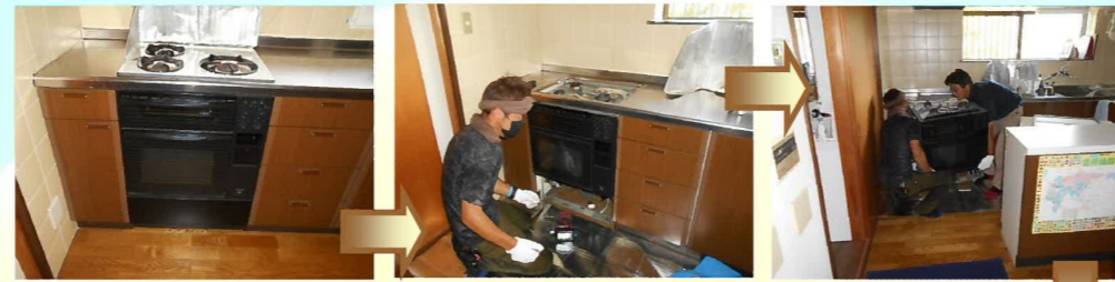
既存のガスコンロとコンベック(オーブン)を取り外します。
