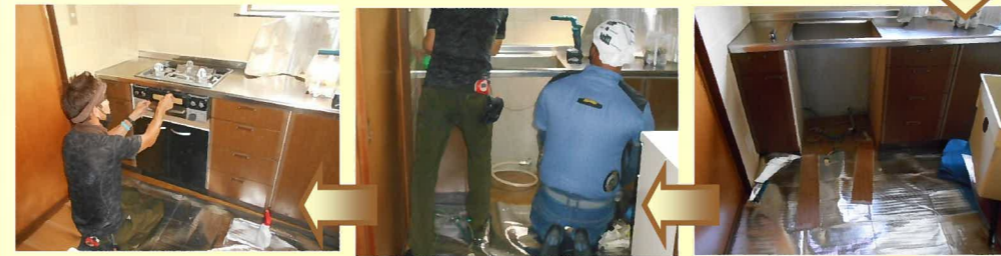
ガスの配管をし直し、新しいガスコンロを取り付けます。コンベック(オーブン)が取り付けがあった場所には、収納キャビネットを取り付けました。
