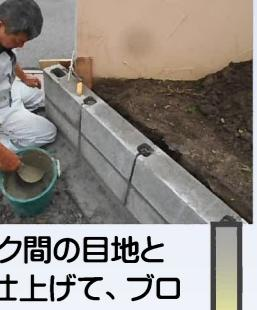
ブロック間の目地と上部を仕上げて、ブロックの周りを埋め戻します。
