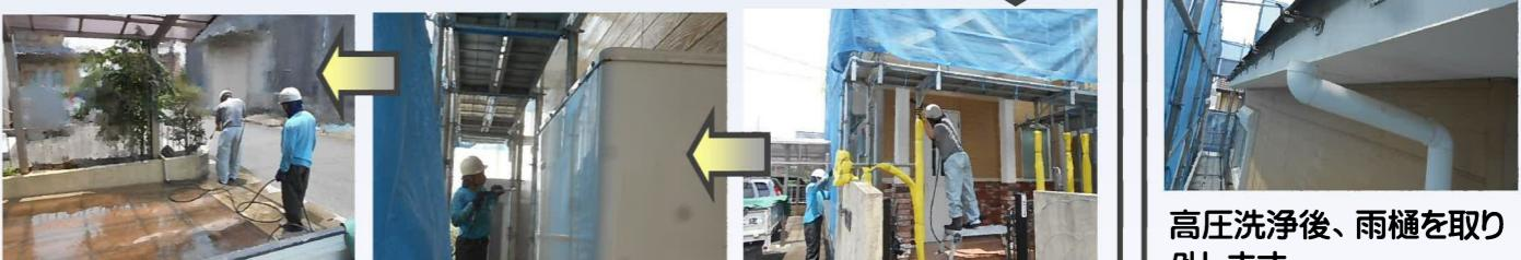
今回はブロック塀も塗装し直すので、高圧洗浄機で汚れを落としておきます。
