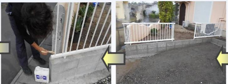
ブロックの切断面の補修を行います。
