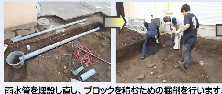
雨水管を埋設し直し、ブロックを積むための掘削を行います。
