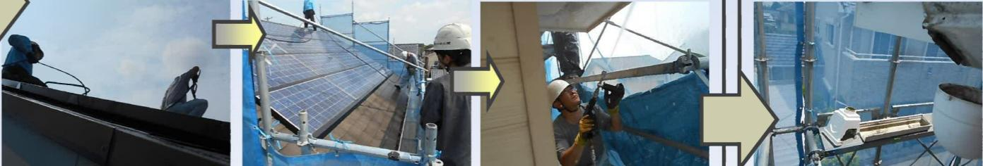
高圧洗浄機を使って長年の汚れを一気に落していきます。
