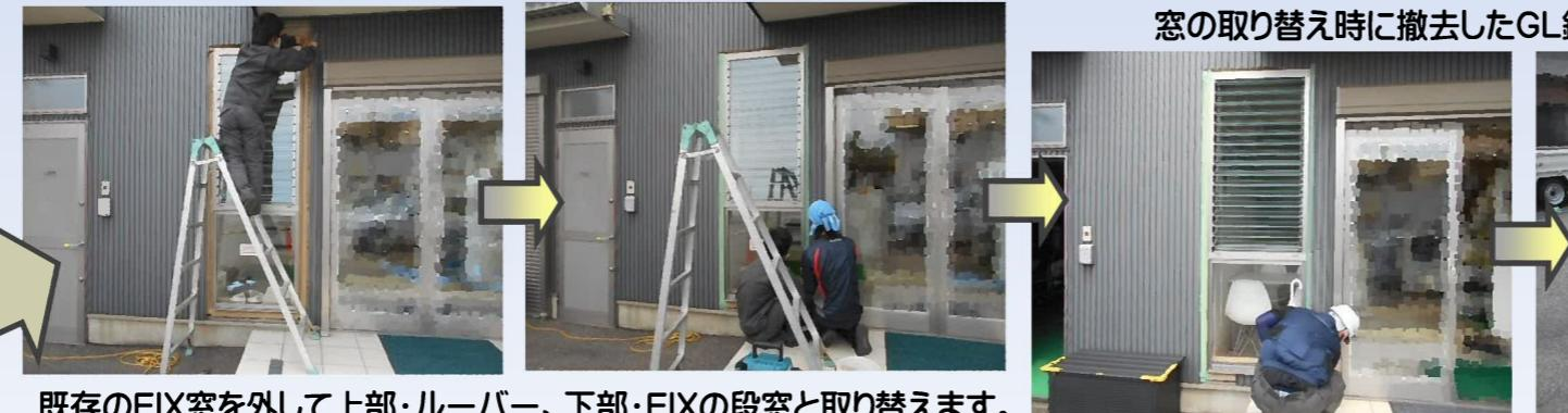
既存のFIX窓を外して上部・ルーバー、下部・FIXの段窓と取り替えます。
