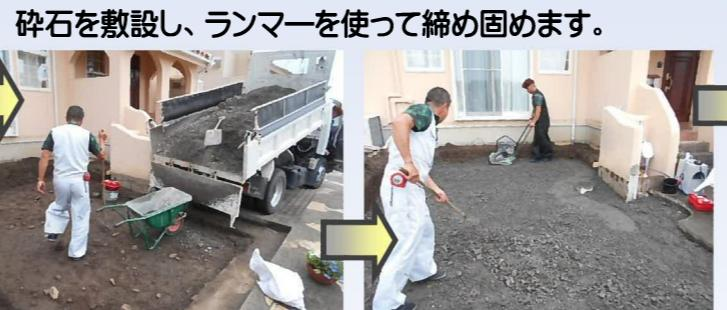
碎石を敷設し、ランマーを使って締め固めます。
