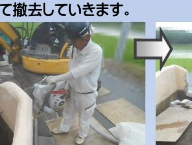
エンジンカッターでブロック塀に切り込みを入れ、重機で倒して撤去していきます。
