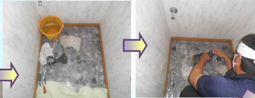
壁や床を傷つけないように注意しながら既存の便器、タンク、便座を撤去し、排水管接続部を外していきます。
