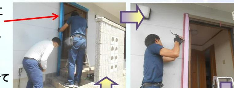
額縫と外壁との隙間にコーキングを充填します。
