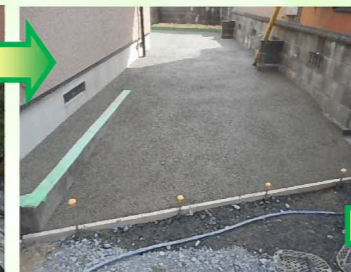
打設から約2~3日後に板枠を外します。透水性コンクリートは乾燥が早いので、翌日には人が乗っても大丈夫です。車の乗り入れは1週間ほどかかります。
