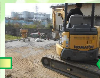
掘削作業を行い、砕石を敷設してランマーで打設し、締め固めます。
