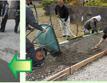
今回の現場は敷地までミキサー車が入りえない為、近隣の駐車場をお借りし、そこでトラックに積み替え現場まで運び、一輪車に載せ替えます。
