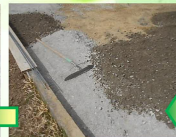
掘削作業を行い、砕石を敷設してランマーで打設し、締め固めます。
