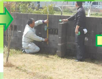
レベル出しを行います。透水性コンクリートを平らに施工するための大切な作業です。
