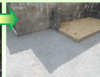
打設から約2~3日後に板枠を外します。透水性コンクリートは乾燥が早いので、翌日には人が乗っても大丈夫です。車の乗り入れは1週間ほどかかります。
