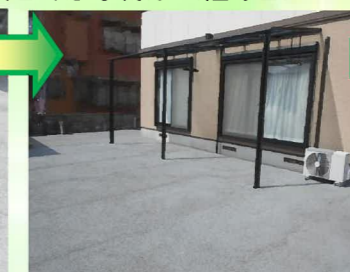
打設から約2~3日後に板枠を外します。透水性コンクリートは乾燥が早いので、翌日には人が乗っても大丈夫です。車の乗り入れは1週間ほどかかります。
