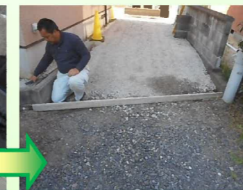
縁に沿って再度除草剤を散布してから板枠を設置し、コンクリートブロックの天端を養生テープで貼っていきます。
