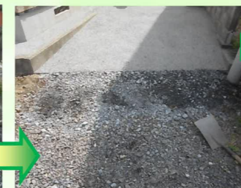
打設から約2~3日後に板枠を外します。透水性コンクリートは乾燥が早いので、翌日には人が乗っても大丈夫です。車の乗り入れは1週間ほどかかります。
