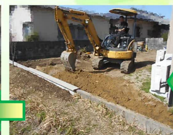
畑と庭の境界に新たにコンクリートブロックを設置します。
