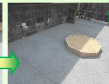
打設から約2~3日後に板枠を外します。透水性コンクリートは乾燥が早いので、翌日には人が乗っても大丈夫です。車の乗り入れは1週間ほどかかります。
