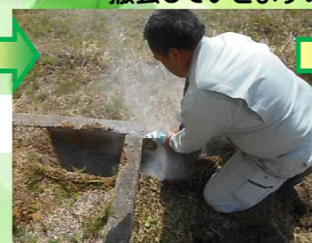
犬走り部分の既存のコンクリートブロックを撤去していきます。
