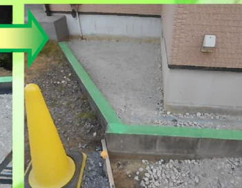
縁に沿って再度除草剤を散布してから板枠を設置し、コンクリートブロックの天端を養生テープで貼っていきます。
