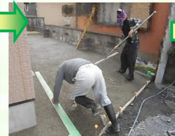
今回の現場は敷地までミキサー車が入りえない為、近隣の駐車場をお借りし、そこでトラックに積み替え現場まで運び、一輪車に載せ替えます。
