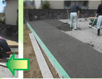
今回の現場は敷地までミキサー車が入りえない為、近隣の駐車場をお借りし、そこでトラックに積み替え現場まで運び、一輪車に載せ替えます。
