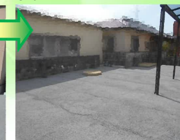
打設から約2~3日後に板枠を外します。透水性コンクリートは乾燥が早いので、翌日には人が乗っても大丈夫です。車の乗り入れは1週間ほどかかります。
