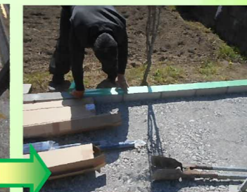
縁に沿って再度除草剤を散布してから板枠を設置し、コンクリートブロックの天端を養生テープで貼っていきます。
