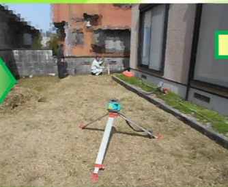
レベル出しを行います。透水性コンクリートを平らに施工するための大切な作業です。
