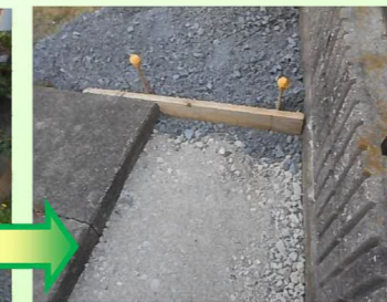
縁に沿って再度除草剤を散布してから板枠を設置し、コンクリートブロックの天端を養生テープで貼っていきます。
