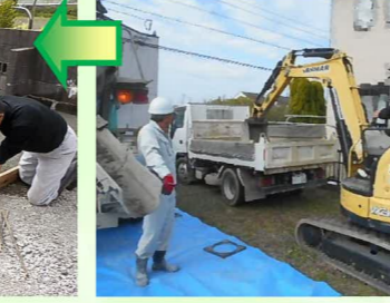
今回の現場は敷地までミキサー車が入りえない為、近隣の駐車場をお借りし、そこでトラックに積み替え現場まで運び、一輪車に載せ替えます。
