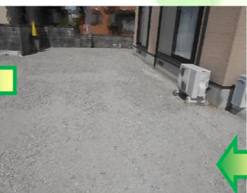
レベル出しを行います。透水性コンクリートを平らに施工するための大切な作業です。
