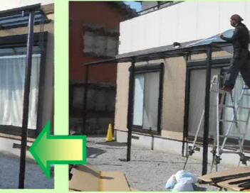
透水性コンクリートの打設前にテラスを設置します。運び込まれた部材を職人さんが手際よく組み立てていきます。
