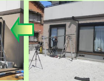
透水性コンクリートの打設前にテラスを設置します。運び込まれた部材を職人さんが手際よく組み立てていきます。
