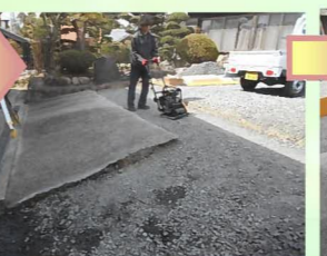
ランマーを使って敷設した碎石の転圧を行い締め固め、型枠を組んでいきます。
