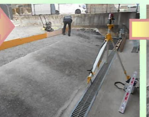
ランマーを使って敷設した碎石の転圧を行い締め固め、型枠を組んでいきます。
