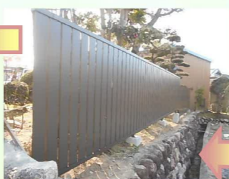
側溝の高さを合わせる為、嵩上げします。
