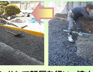
透水性ドライテックを運び込んで均していき、ランマーとタンパ°で転圧を行い、締め固めて仕上げていきます。
