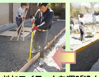
透水性ドライテックを運び込んで均していき、ランマーとタンパ°で転圧を行い、締め固めて仕上げていきます。
