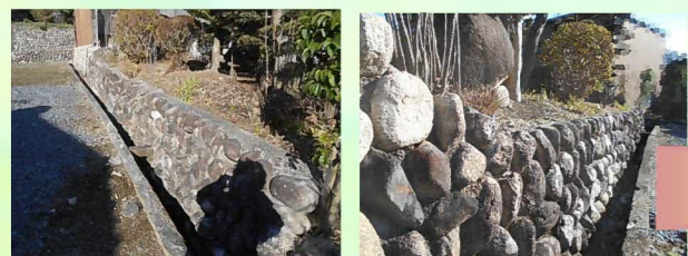
玉石土留めの上に目隠しフェンスを設置します。
