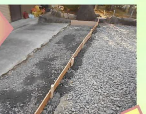
ランマーを使って敷設した碎石の転圧を行い締め固め、型枠を組んでいきます。
