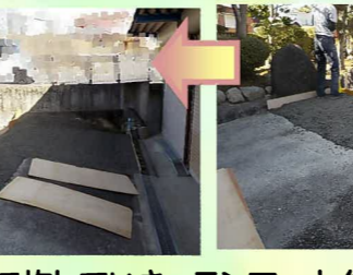
透水性ドライテックを運び込んで均していき、ランマーとタンパ°で転圧を行い、締め固めて仕上げていきます。
