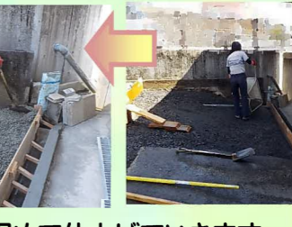
透水性ドライテックを運び込んで均していき、ランマーとタンパ°で転圧を行い、締め固めて仕上げていきます。
