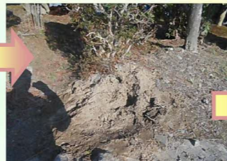
フェンスを立てる為に障害になる木を撤去します。
