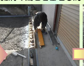
側溝の高さを合わせる為、嵩上げします。
