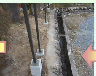
ランマーを使って敷設した碎石の転圧を行い締め固め、型枠を組んでいきます。
