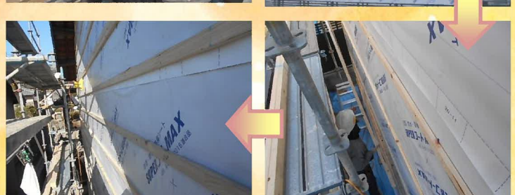
外壁の下地木棧を取り付けていきます。
