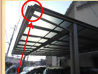
コーナーキャップが割れてしまっている状態でした(>_<)
