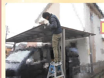
破損したコーナーキャップを取り外します。
