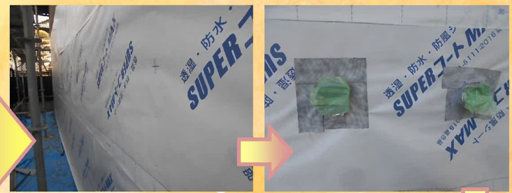
透湿防水シートを貼っていきます。
