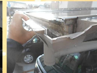
コーナーキャップが割れてしまっている状態でした(>_<)
