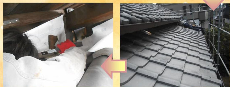
下屋と大屋根の間にもぐり込んで壁にしっかりと透湿防水シートを貼っていきます。
