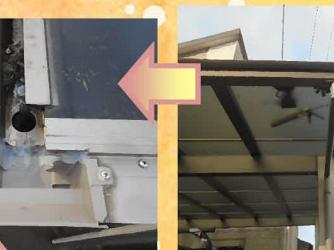
破損したコーナーキャップを取り外します。
