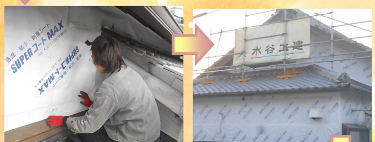
下屋と大屋根の間にもぐり込んで壁にしっかりと透湿防水シートを貼っていきます。
