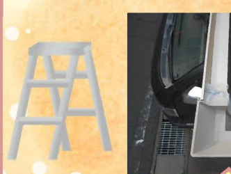
破損したコーナーキャップを取り外します。
