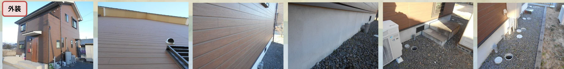
外回りのチェックから始めます。基礎や外壁、軒天などがひび割れや破損がないか目視でチェックしていきます。
