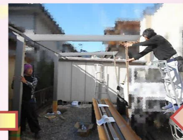
屋根部分を組み上げていきます。
