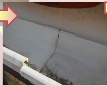
ジョイントの一部が破損し、軒樋が外れ掛けている状態でした。
