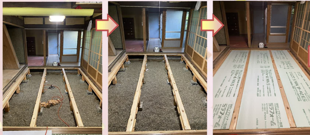
大引に断熱受けを取り付けます。
