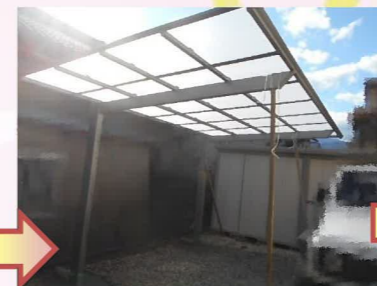
仮固定してあった支柱部分を水平器を使って真っすぐ立っていることを確認しながら生コンで固定し、固まるまで添え木を立てておきます。
