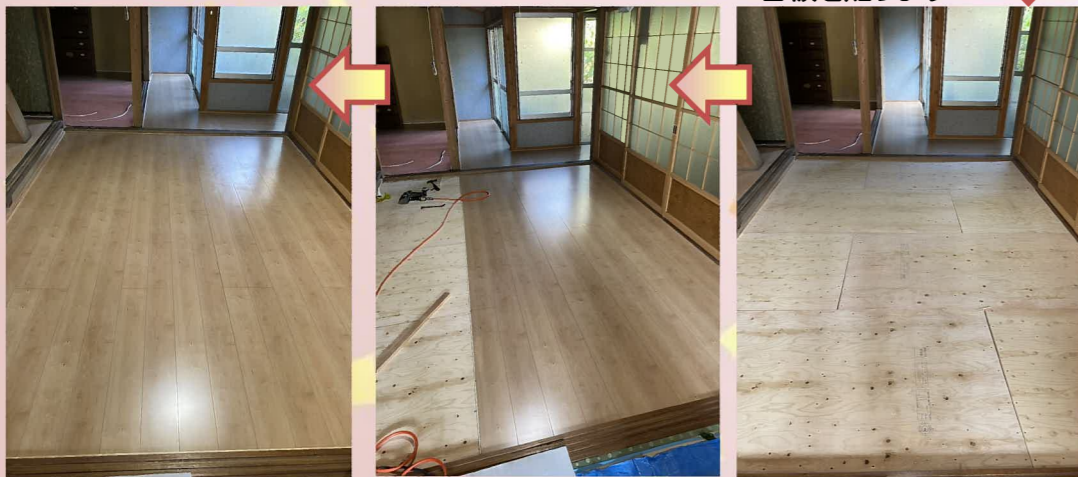
仕上げのフロア材を貼り、居間の床修繕工事完了です。
