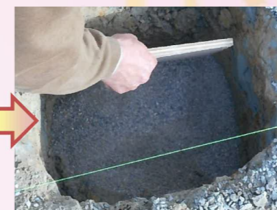
必要な深さまで掘ったら生コンを打設し、基礎を作ります。
