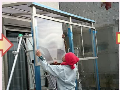
前面にスクリーンを1段設置するので枠を組み、ポリカーボネートをはめ込んでいきます。
