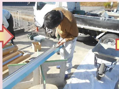
前面にスクリーンを1段設置するので枠を組み、ポリカーボネートをはめ込んでいきます。
