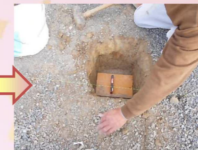
必要な深さまで掘ったら生コンを打設し、基礎を作ります。
