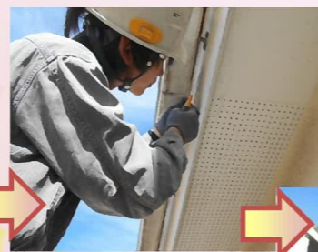
割れて残っていたジョイントを撤去します。
