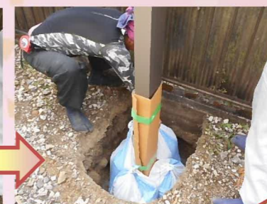
支柱を立て、土のうでしっかり仮固定します。
