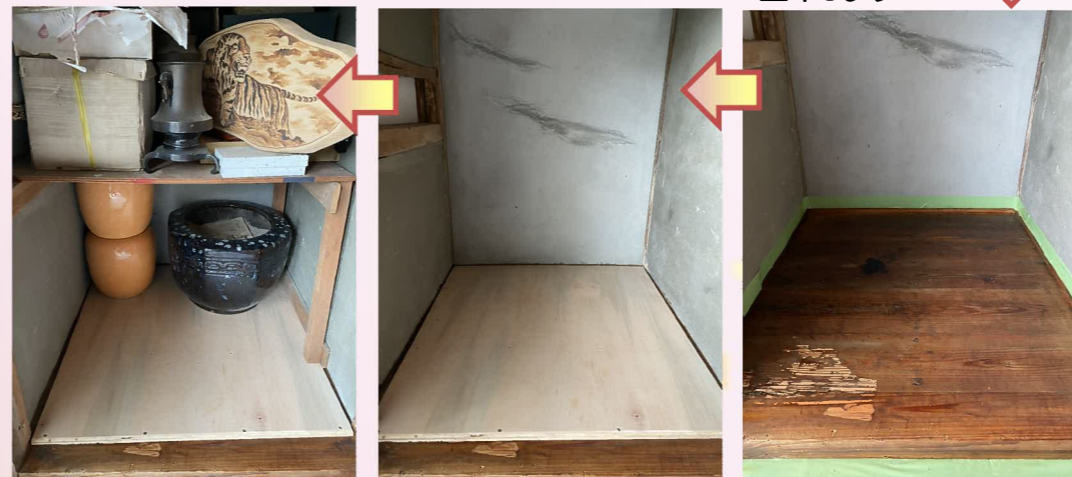
防腐防蟻剤が乾いたらラワンヘビニヤを貼って、仕切り棚を戻して工事完了です(^o^)/
