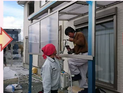
前面にスクリーンを1段設置するので枠を組み、ポリカーボネートをはめ込んでいきます。
