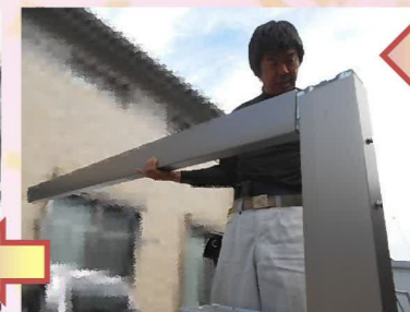
支柱を立て、土のうでしっかり仮固定します。
