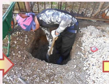
支柱を立てる為の穴を掘っていきます。
