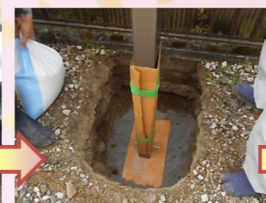
支柱を立て、土のうでしっかり仮固定します。
