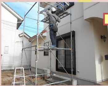
ジョイントの一部が破損し、軒樋が外れ掛けている状態でした。
