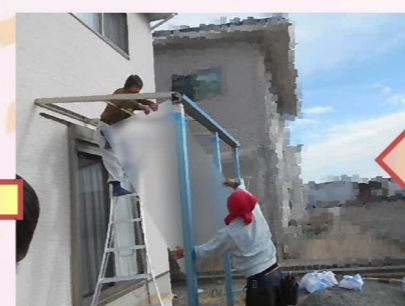
屋根部分を組み上げ、ポリカーボネートを1枚ずつ貼っていきます。
