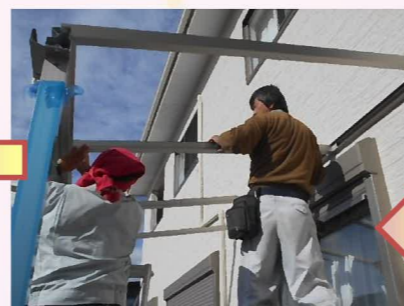
屋根部分を組み上げ、ポリカーボネートを1枚ずつ貼っていきます。
