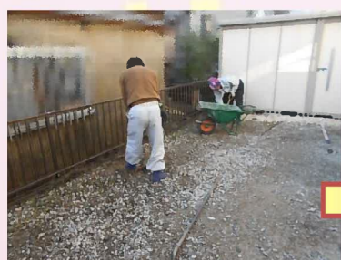
支柱を立てる為の穴を掘っていきます。
