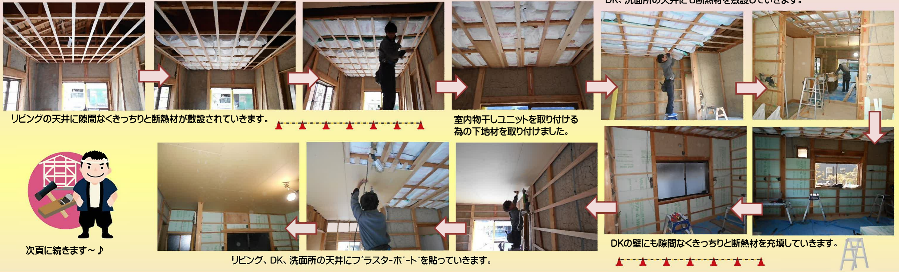
DK、洗面所の天井にも断熱材を敷設していきます。
