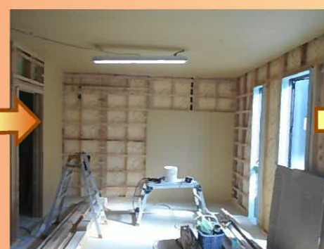
↑ ちょっとわかりづらいですが、この部分にも断熱材が充填されています！
