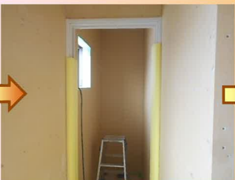
内装建具枠が取り付けられました。キズや汚れが付かないように養生をしておきます。
