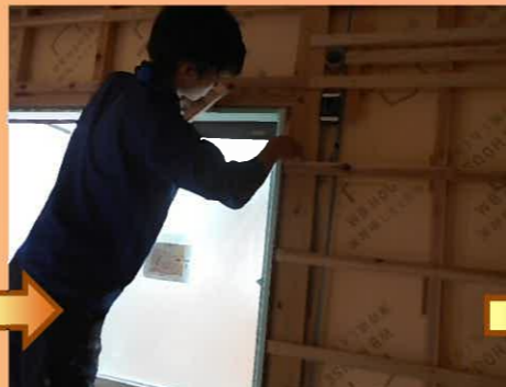
↑ ちょっとわかりづらいですが、この部分にも断熱材が充填されています！
