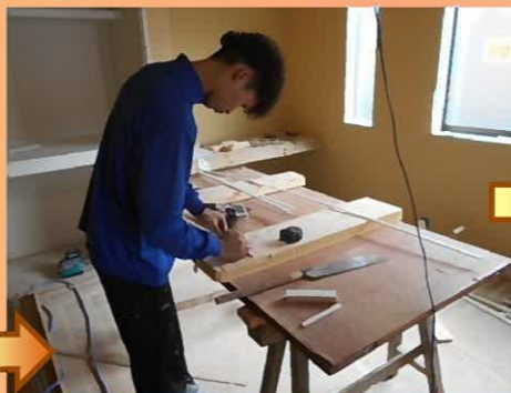
収納部分には枕棚と中段を取り付けていきます。
