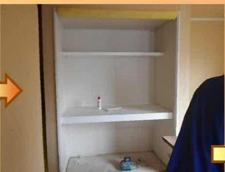
収納部分には枕棚と中段を取り付けていきます。
