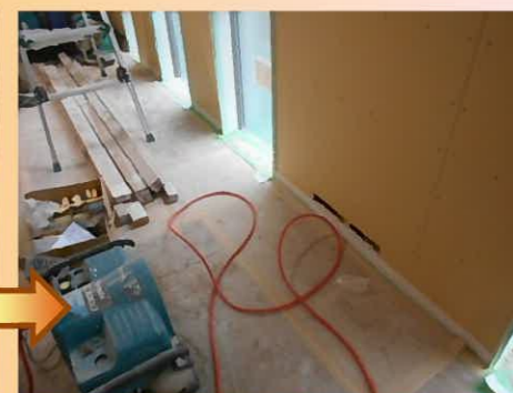
寸法を確認しながら幅木を取り付けていきます。
