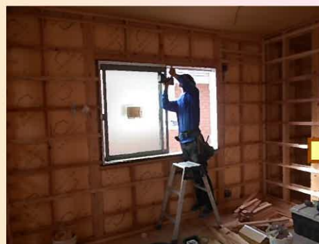
一カ所ずつ窓枠を取り付けていきます。
